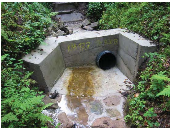
Der fertige Entwässerungseinlauf in Km 17,7
